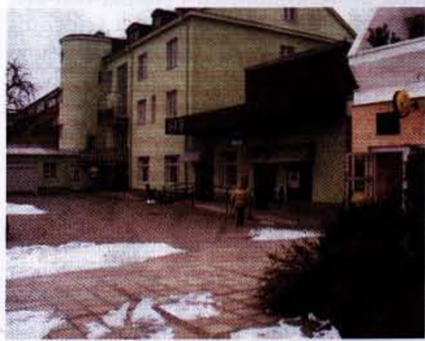
Domusparkeringen för ombyggnad
